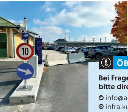
Das neue ÖBB Zufahrtssystem bei der P&R-Anlage in der Salzburger Straße ging Mitte Oktober 2025 in den Probebetrieb und wird ab Februar 2026 kostenpflichtig!
